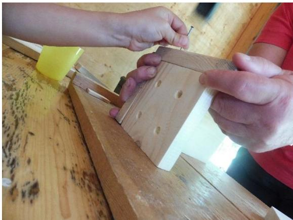
Nun wird der Boden befestigt. Achte darauf, dass der Boden mit den Kanten des Seitenteils und der Rückwand gut abschließt, bevor du ihn mit zwei Nägeln der Länge 4 cm an den Vorbohrungen der Seitenteile befestigst.
